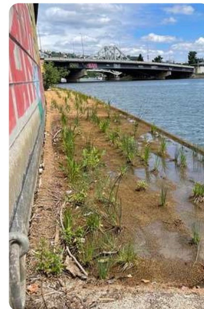
Création d'un coffrage en bois d'aulne, apport de substrat, installation d'un tapis en fibres de coco tressées biodégradables, plantations et développement
